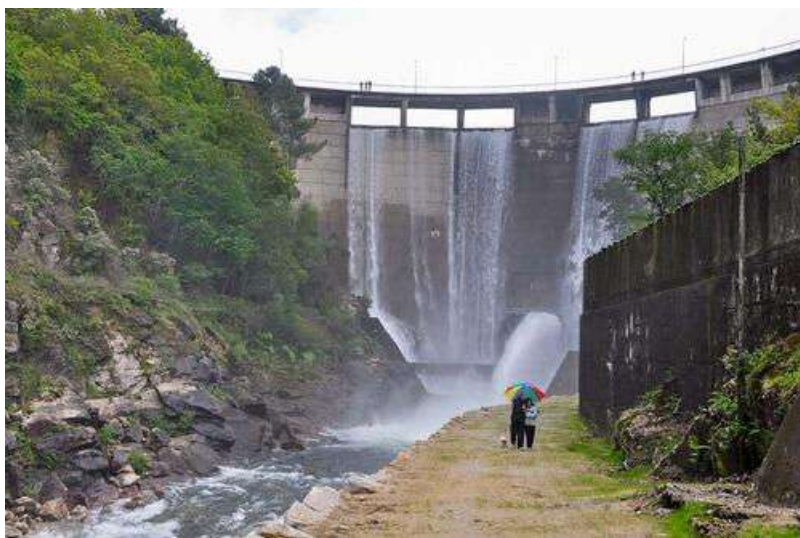
Imagen de la presa de Eiras. Turismo Rías Baixas
