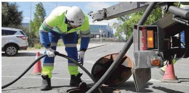
Las fibras de las toallitas húmedas ensucian las máquinas de limpieza. FOTO: AIGÜES DE REUS
