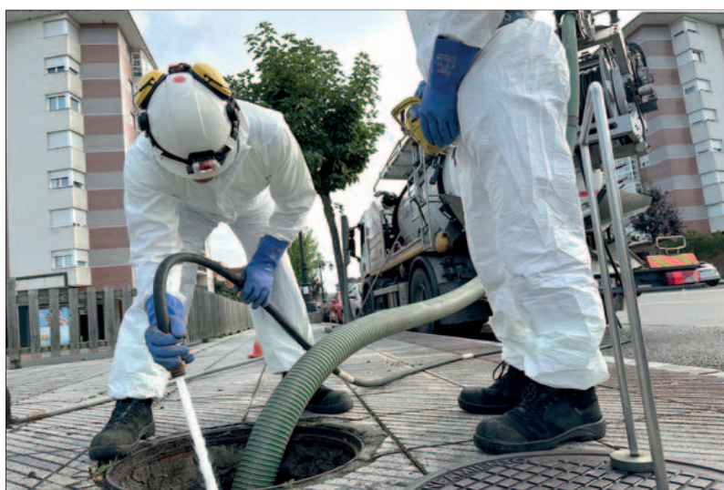
CON EL MONO DE TRABAJO. Operarios limpian un sistema de alcantarillado con un posible atasco.
