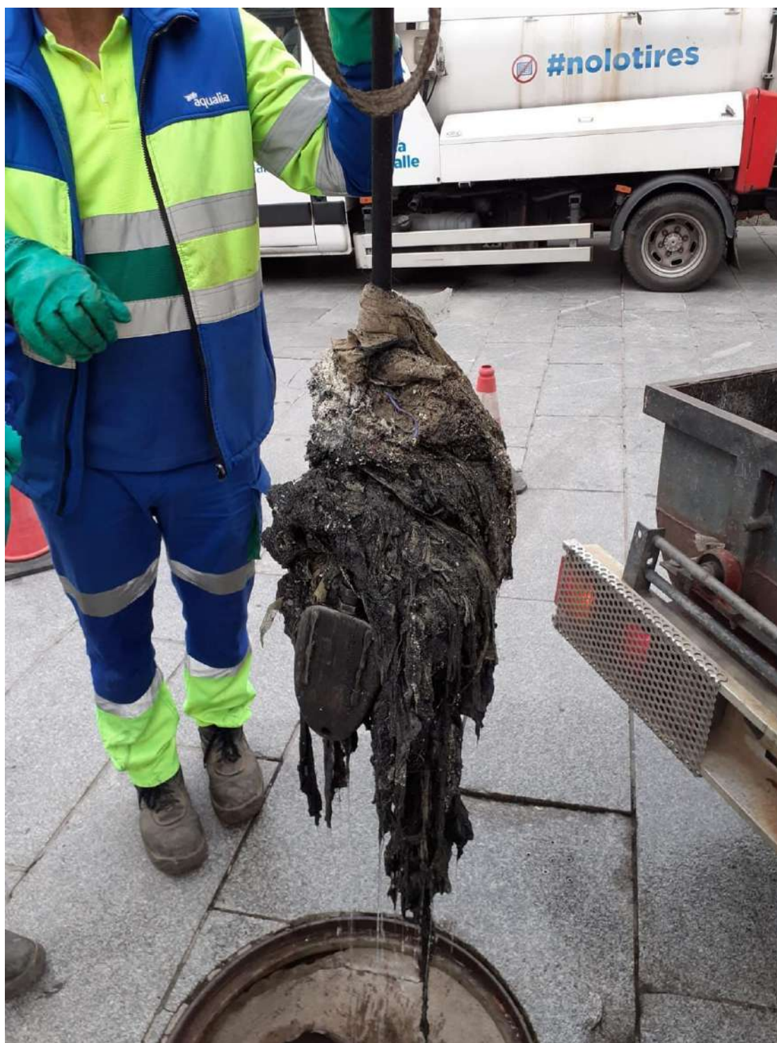
Operario de Aqualia extrayendo residuos de la red de saneamiento de Mérida. / AQUALIA
