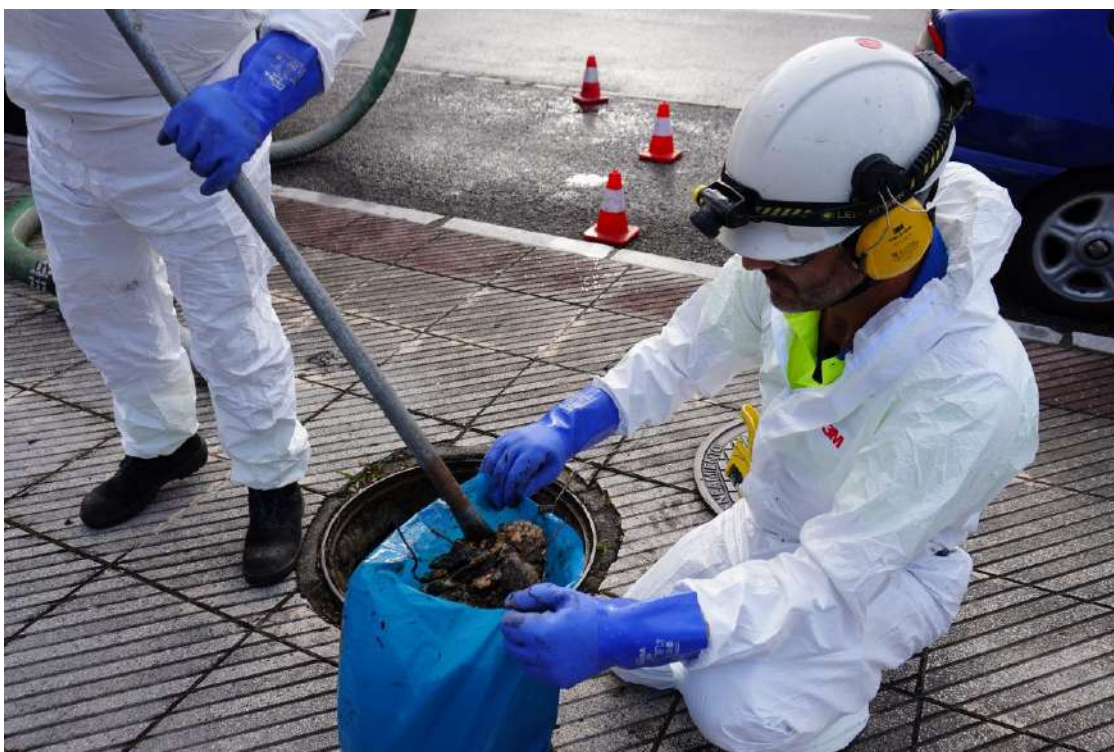
Acciones de limpieza en la red de saneamiento
