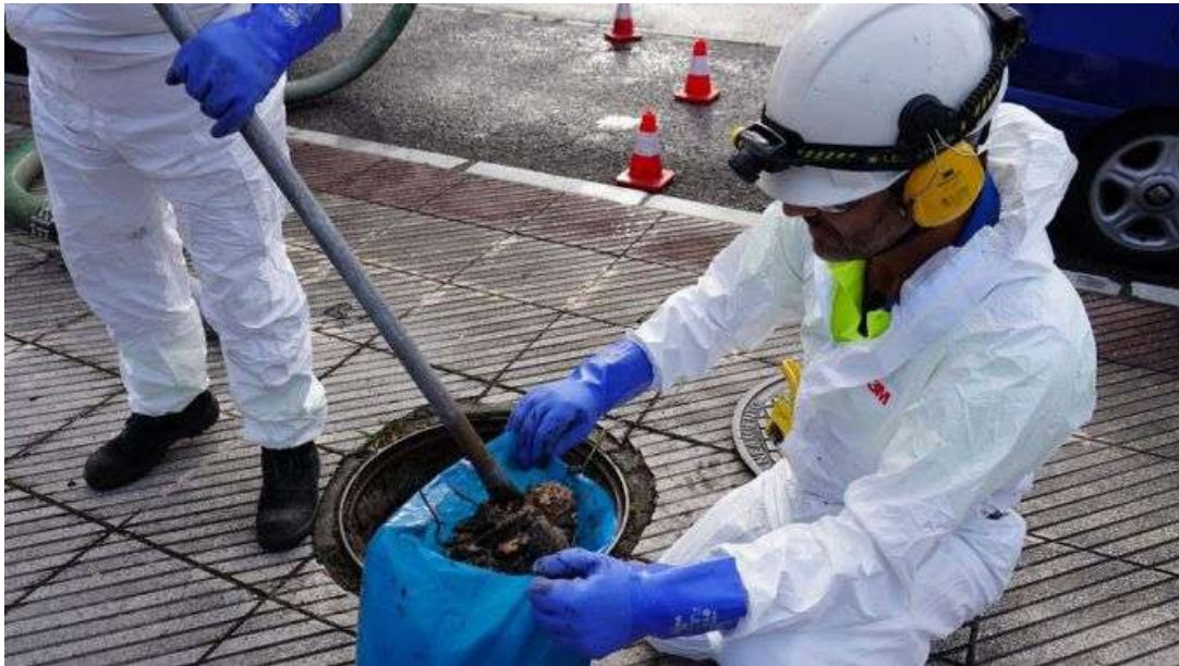
Labores de limpieza en la red de saneamiento
