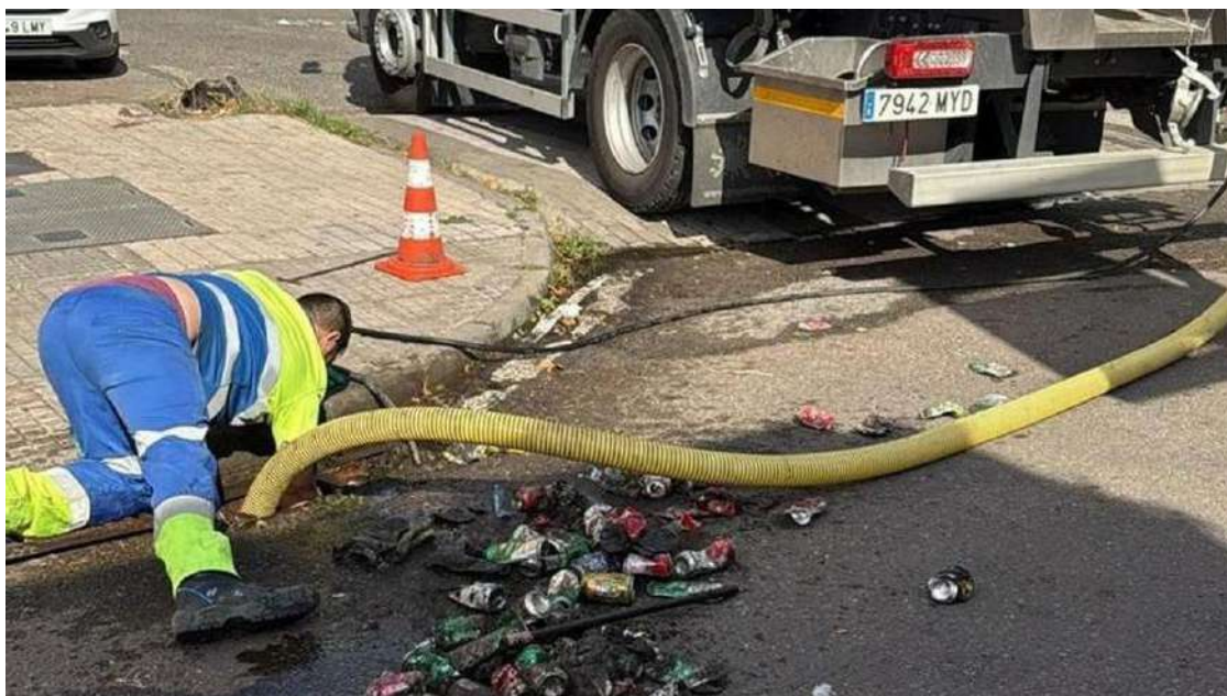
Operario de Aqualia, junto a camión bomba, durante trabajos de limpieza de la red de saneamiento.
